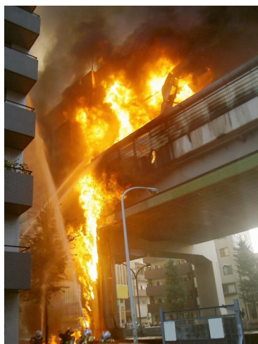
平成20年 首都高速道路 で発生したローリー火災 (写真提供：東京消防庁)
