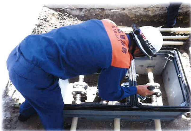
《危険物施設 配管検査》
