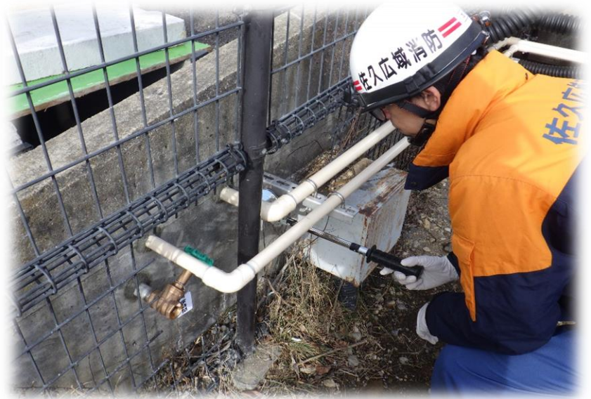
《危険物施設 配管検査》
