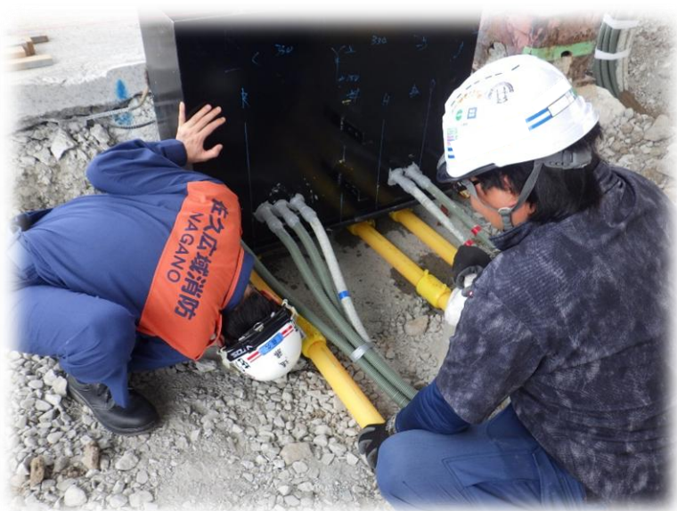
《 危険物施設 配管検査 》
